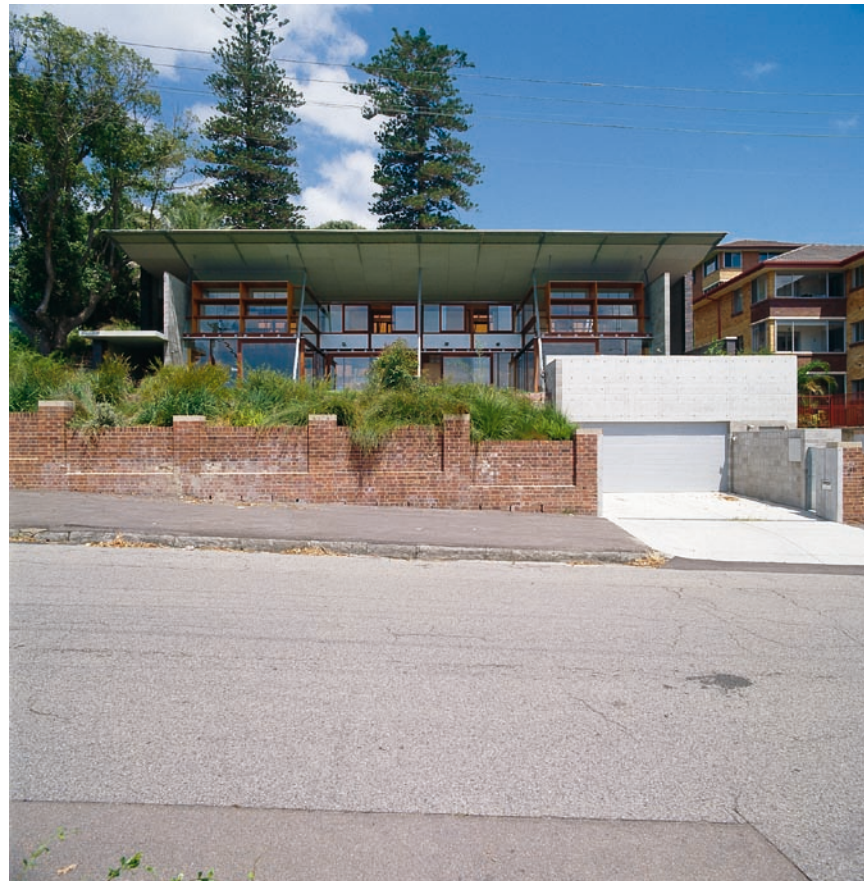
Eingenistet: Ein scheinbar schwebendes Dach schützt den zur Hälfte im Hügel eingegrabenen Baukörper.
