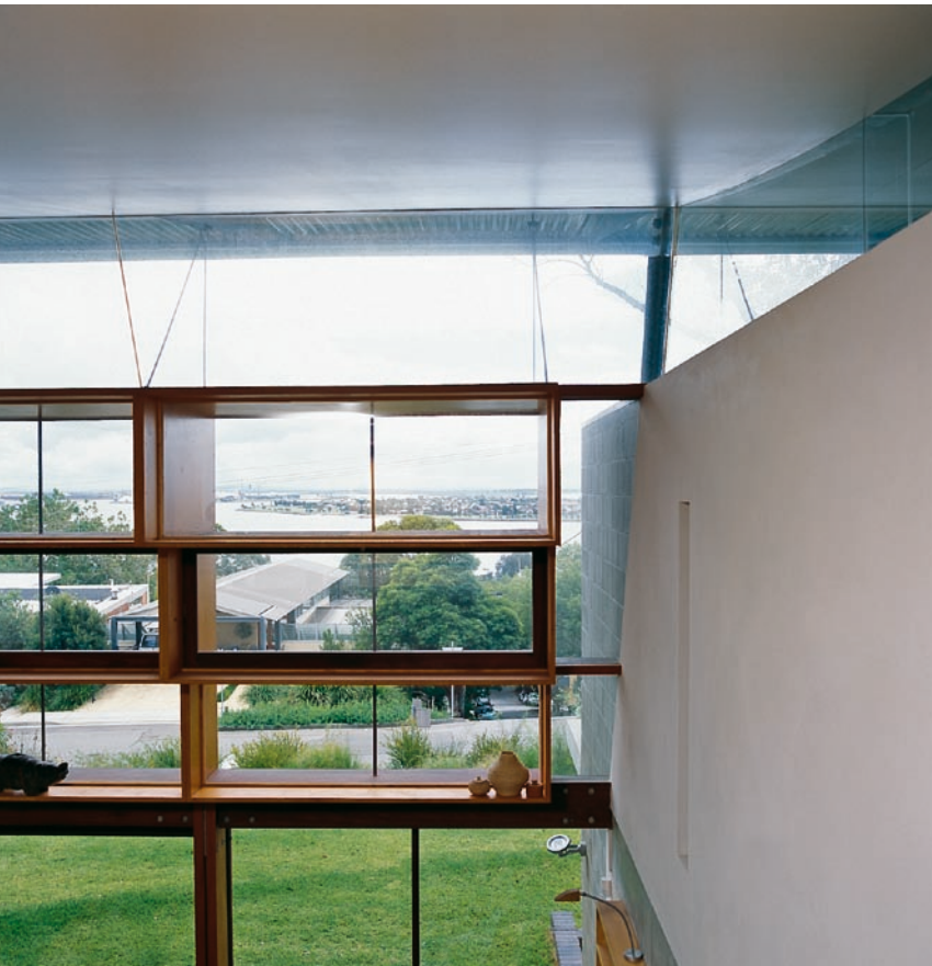
Brises-Soleil: Sperrholzelemente brechen das helle australische Nordlicht, ohne die Sicht auf den Hudson River zu verstellen.
