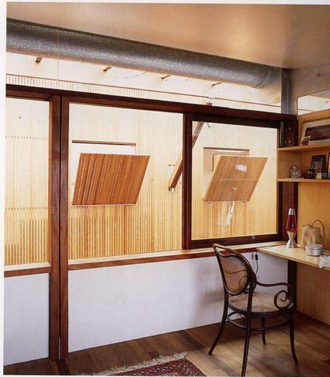
Опорно-балочная деревянная конструкция, основной структурный элемент интерьера, служит также для зонирования помещений: на верхнем уровне сформированы «ячейки», в которых располагаются спальни и комнаты отдыха
